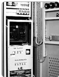
RB (Rectifier & Battery)
