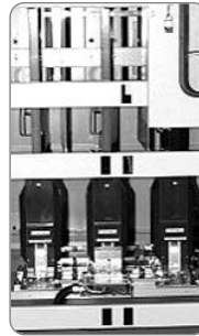
MOF (Metering out fit)
